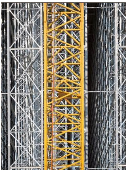
Blick auf ein Gerüst. Foto: Josef Bachner
